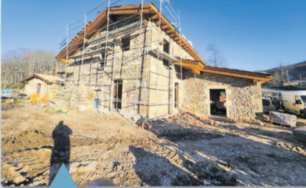
Construcción de Hotel Rural en Las Machorras
