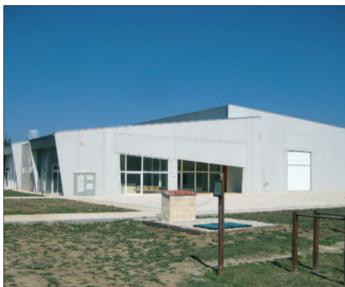
En el polideportivo se colocarán 133 placas que suman una potencia de 59,9kW.
