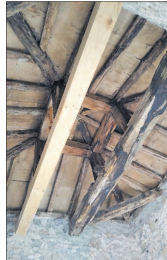
Se ha cambiado una de las vigas principales del campanario.
