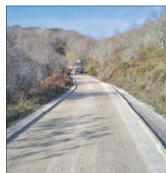
Asfaltado de la Pista de Rioseco.
