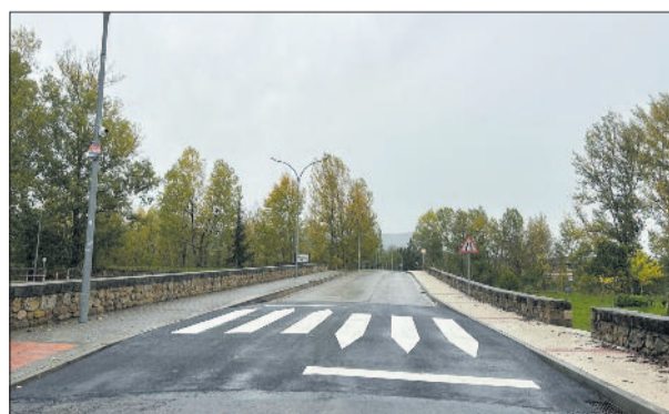
Puente de “Las Medinas”.
