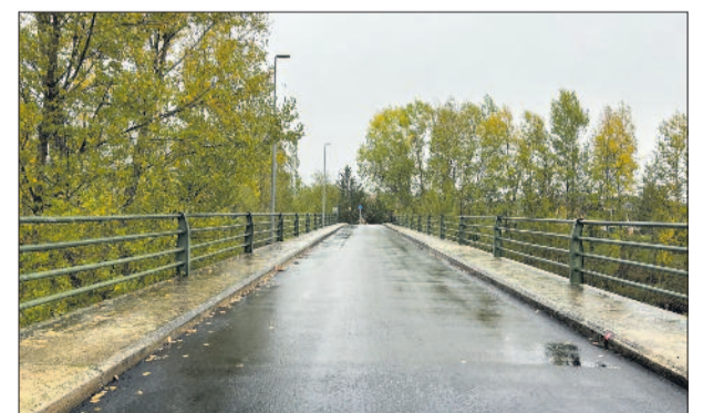
Puente de “Las Medinas”.
