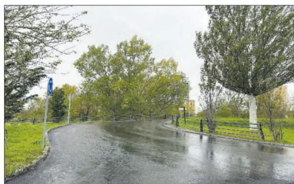
Puente de “Las Medinas”.
