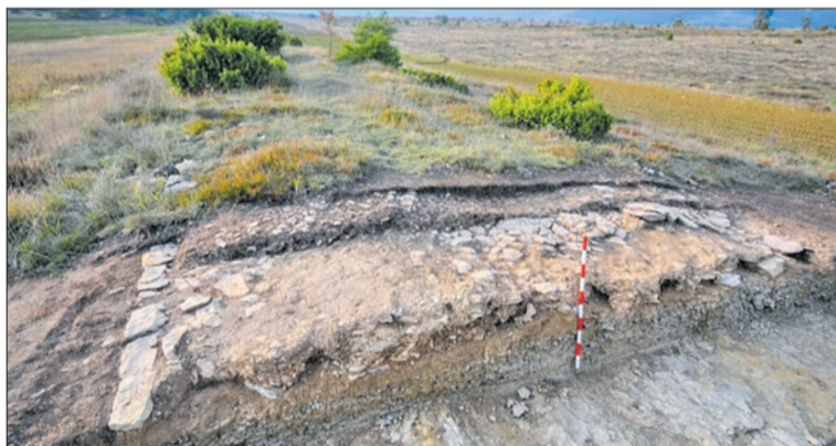
Corte transversal de la calzada de Losa donde se aprecian los materiales con la que se construyó.
