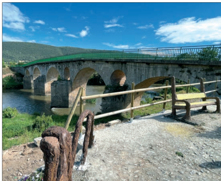
Puente de Puentearenas de Valdivielso.
