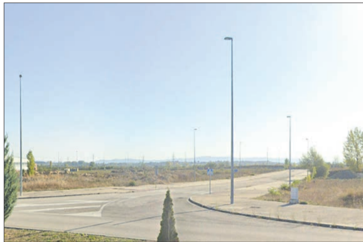
Una de las zonas del polígono donde se han sustituido la iluminación.
