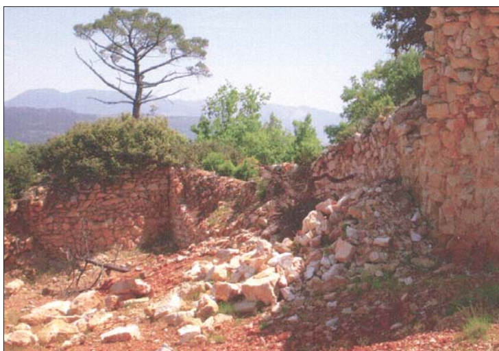
► Fase de las excavaciones en la muralla del castillo
