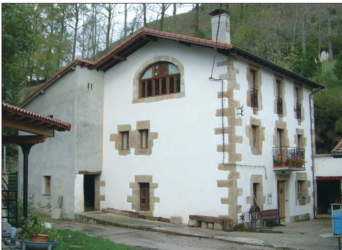
► Edificio que guarda la instalación y máquinas
