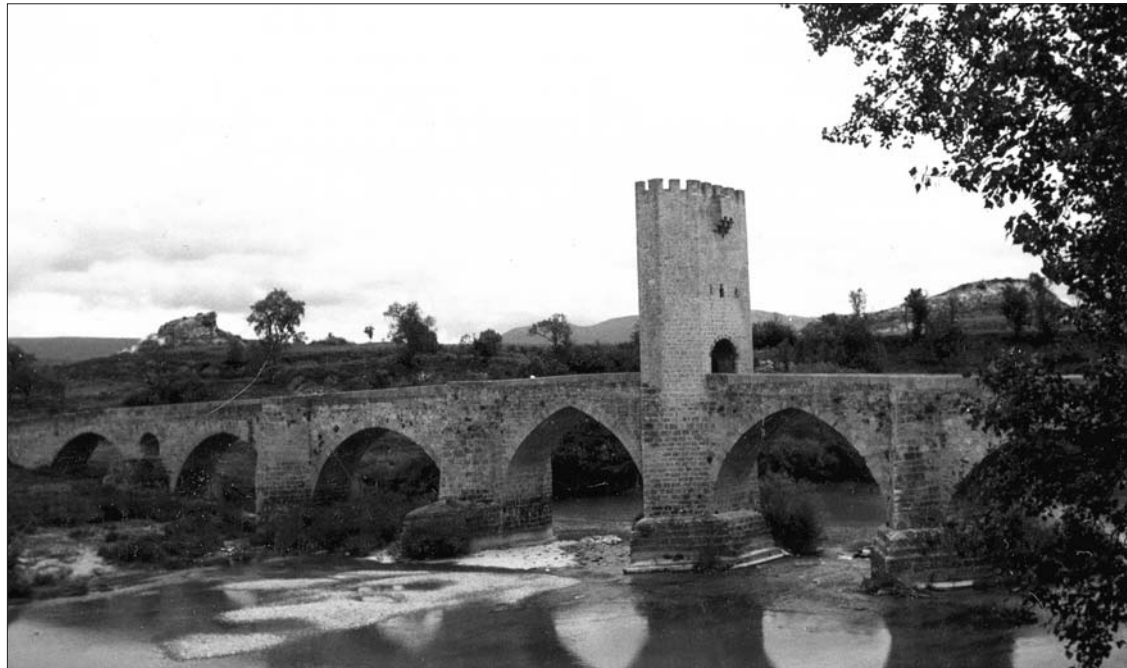
► El puente medieval de Frías tuvo un peso importante en las intervenciones de Longa.
